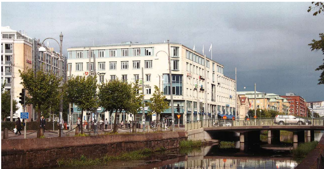
Foto från öster som visar byggnadens befintliga utseende. Foto från GAJD Arkitekter
